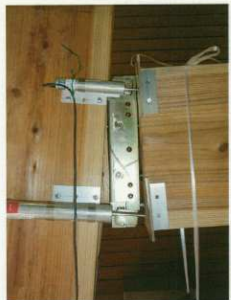
No. 4 試験体 反ジャッキ側接合部の破壊状況
