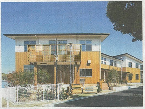
国産材にこだわった木造建築の優位性を発揮した障害者福祉施設
