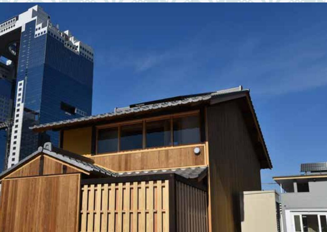
業(株)が有するスーパーサーモ処理(水蒸気式高温熱処理技術)を施して、防腐性能・寸法安定性を確保した外装用製材製品。水分と熱のみのノンケミカル(化学薬品無使用)にて、無垢材の美しさをそのままに、高耐久性を実現した国産無垢材の木製サイディングです。
