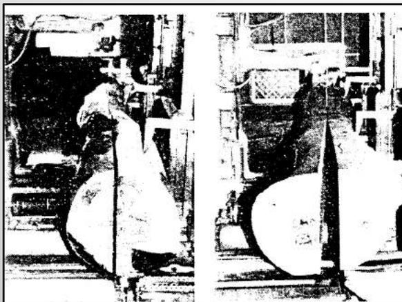
丸太を半割りにすると、右:無処理材には成長応力による反りが現れ、徐々に大きくなる。しかし、左:熱処理すると応力が緩和されるために、反りは生じない。
