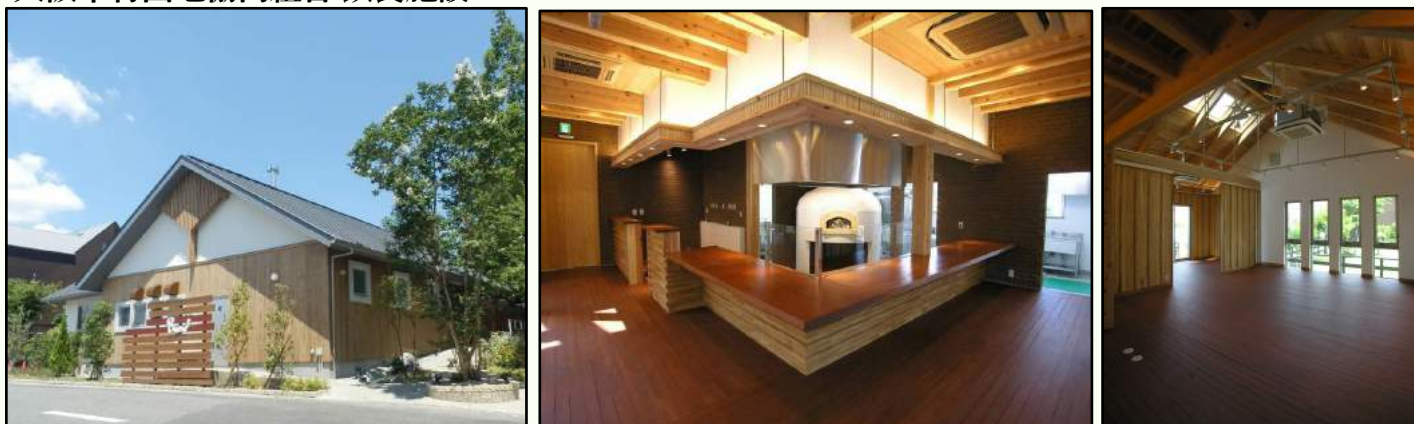
2012年7月竣工 堺市美原区 杉無垢板水平構面の勾配応用と外壁開口部の杉無垢製材門型ラーメンフレーム採用事例 意匠設計：DID建築設計事務所 式田 完 構造設計：明月社 山岸 飛鳥 施工：コアー建築工房株式会社
