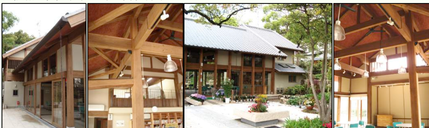
2007年3月竣工 杉・桧無垢材の燃えしろ設計現し工法事例 設計：有限会社 菅家設計室 菅家 克子 施工：株式会社 高田工務店
