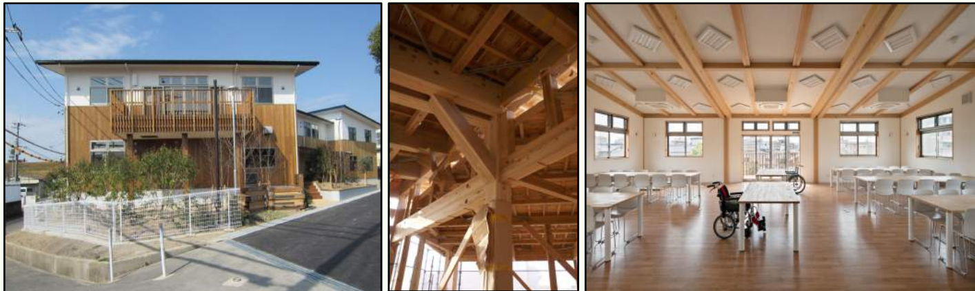
2016年3月竣工 大阪府守口市内福祉施設におけるSSD球磨杉Jポスト&ビーム燃えしろ設計採用事例 意匠設計：(有)ものづくり伊東設計工房 伊東正市 構造設計：(株)関西木材工業植森貞友 施工：太平建設工業株式会社
