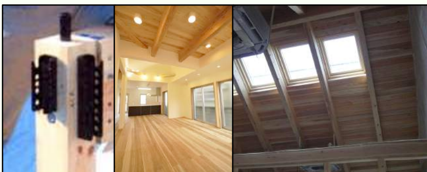
写真左は杉製材接合耐力データを有するHSS金物、写真中・右は杉無垢板床倍率を採用した現し工法の例
