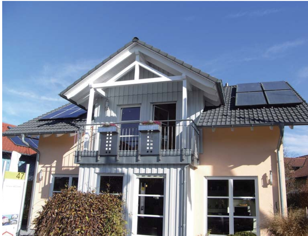
〔5〕 太陽温水器・太陽光発電を載せた住宅
